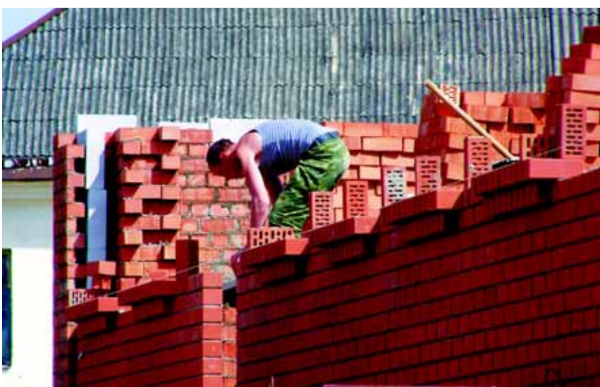
Рис. 1. Конструкция трехслойной кирпичной стены с эффективным утеплителем (пенополистирольные плиты ПСБ-25)
